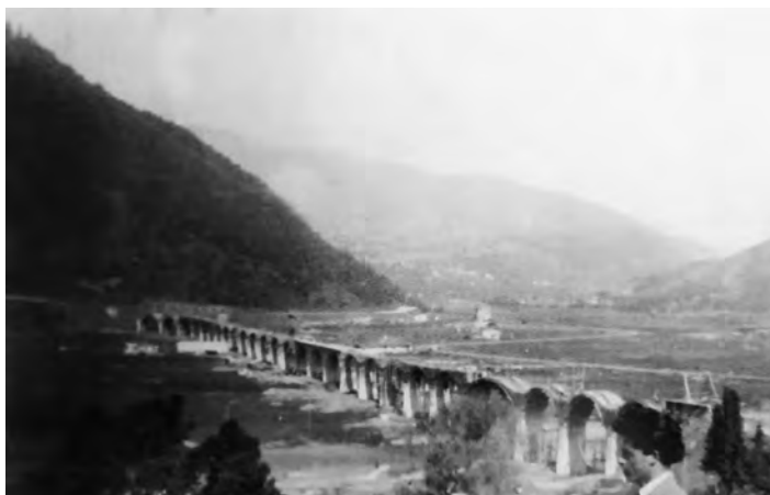
Viaductul în construcție, cu puțin timp înainte de eliberarea Părintelui Justin
